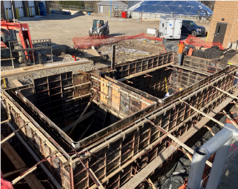
Str. 75 Formwork & Reinforcing Steel for Concrete Pour
